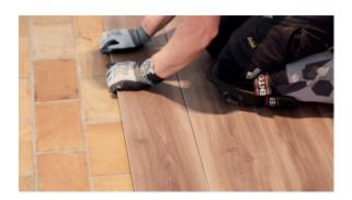
Zum Einfügen der letzten Plankenreihe müssen die Planken in der Regel zugeschnitten werden. Legen Sie dazu eine Planke deckungsgleich auf die vorletzte Reihe, legen Sie eine weitere Planke obenauf und positionieren Sie diese mit der Außenseite direkt zur Wand. Zeichnen Sie ihre Vorderkante auf der Diele darunter ein. Berücksichtigen Sie dabei den einzuhaltenden Randabstand. Jetzt können Sie diese Planke passend zuschneiden und zusammen mit den anderen Planken der letzten Reihe einrasten.
