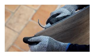
Legen Sie die Planke mit den abgeschnittenen Seite an die Wand an. Verwenden Sie die Abstandhalter zum Einhalten des umlaufenden Randabstands, als stabiles Gegenlager um ausreichend Druck beim Einrasten einwirken zu lassen und um die Unebenheiten der Wand auszugleichen. Für einen absolut geradlinigen Verlauf der Plankenreihen ist zu sorgen.
